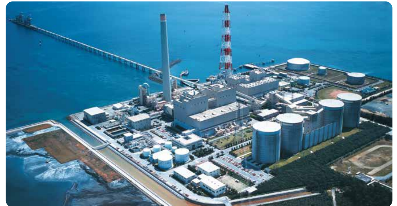
総出力312MWの発電所。日本の発電所で初めてMDM-TR方式払出サイロ(31,000ton×4基)を導入した発電所です。
