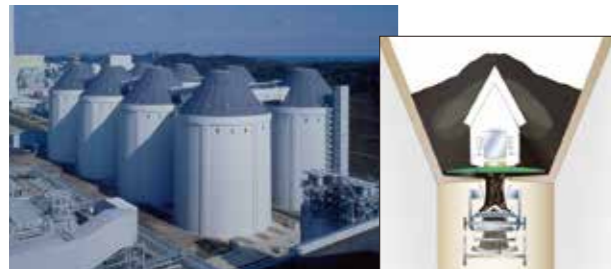
MDM-TR方式サイロ貯蔵システム 取扱物：石炭、石灰石など
