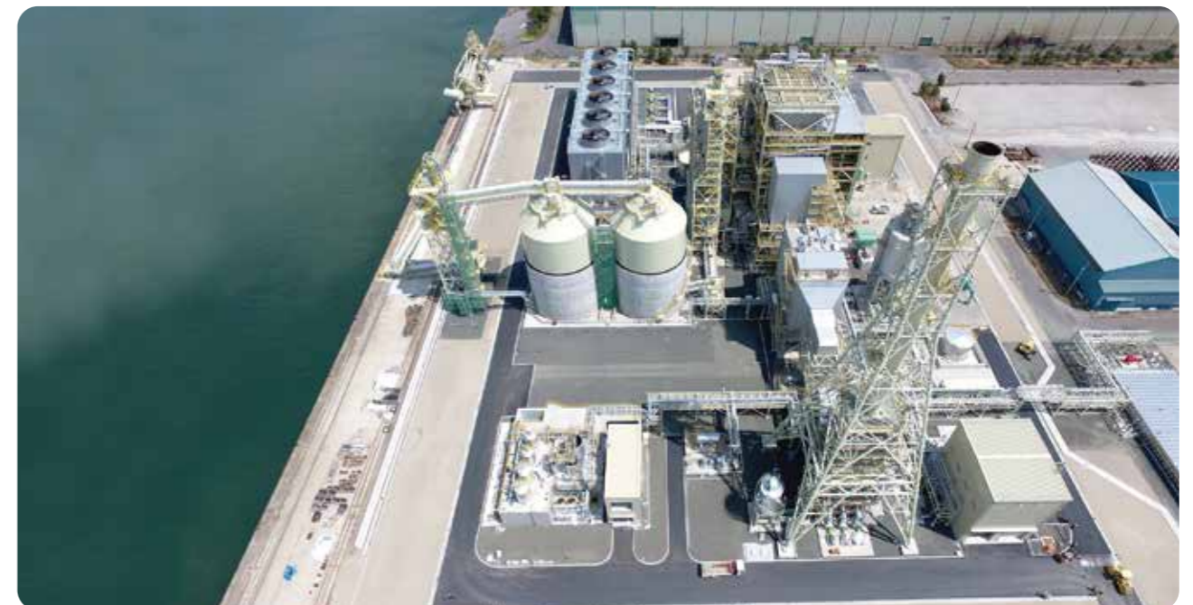
出力規模112MWの石炭火力発電所。環境配備の為、密閉性に優れたMDM-FR方式サイロ(4,000m 3 ×2基)を採用しています。
